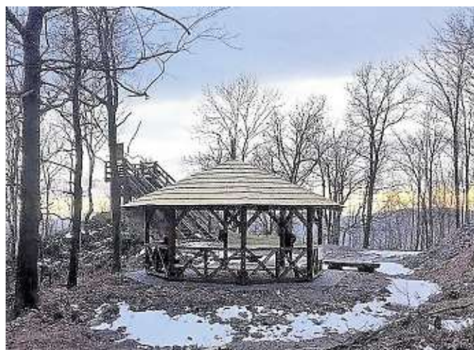
Dieser Altan wurde als Rastplatz für Wanderer errichtet, die es auf den Gickelsberg zieht.
